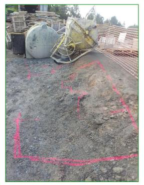
Identification d'une zone pour installer le bassin Cette zone est choisie en fonction des contraintes du chantier (en dehors des zones de circulation, de stockage et de construction) et sera conservée (dans la mesure du possible) pendant toutes les phases d'utilisation du béton.
