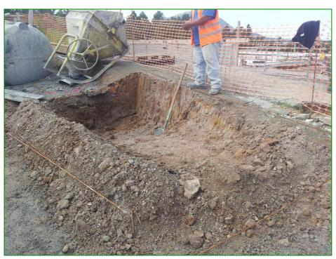
La dimension du bassin est fonction des quantités de béton à traiter et de la place disponible sur le chantier.
