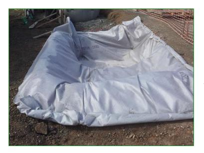
Ce bassin est semi-perméable : géotexile qui laisse l'eau s'infiltrer et retient les particules fines.
