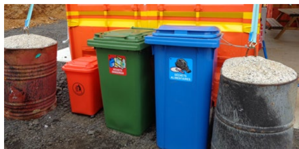
Photo 11 : stockage des déchets au niveau des installations de chantier, Lotissement Niaoulis. Crédit : CCI-NC.
