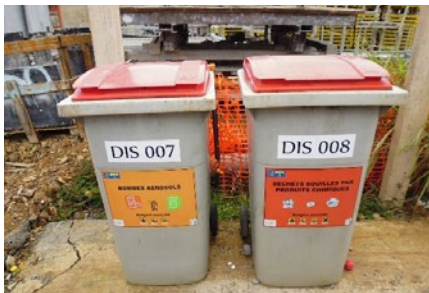
Photo 8 : stockage des déchets dangereux, bacs de 240 L. Crédit : CCI-NC.
