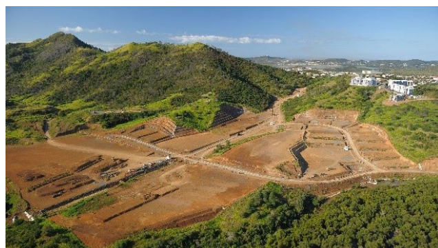
Photo 2 : vue aérienne chantier aménagement T2.3.1, Dumbéa-sur-Mer. Crédit : SECAL
