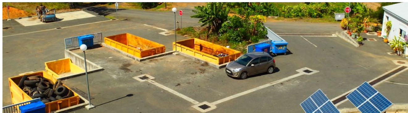
Photo 4 : Déchèterie de La Foa. Crédit : SIMM Sud
