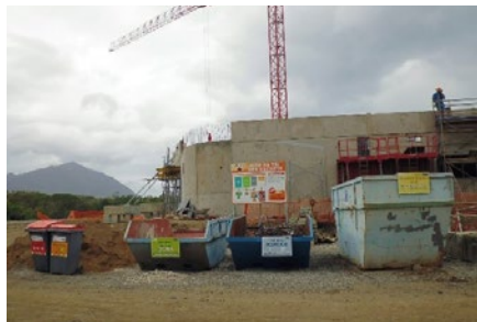
Photo 7 : zone de tri principale, chantier du lycée du Mont Dore. Crédit : CCI-NC.
