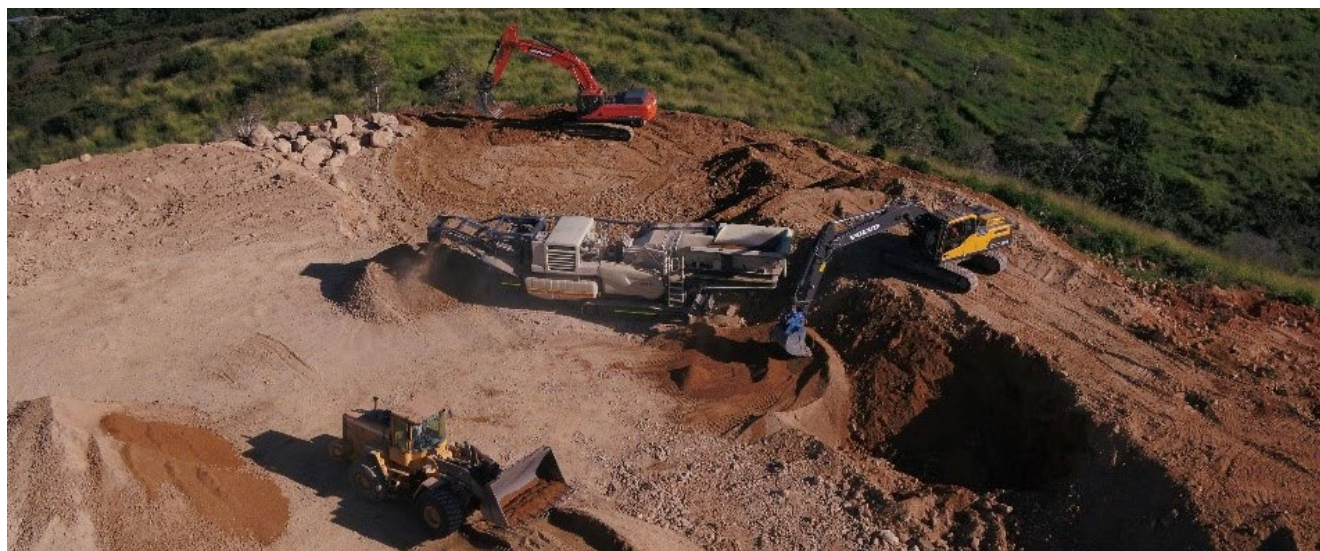
Photo 3 : broyeur-concasseur de déblais, chantier Les Niaoulis. Crédit : Colas
