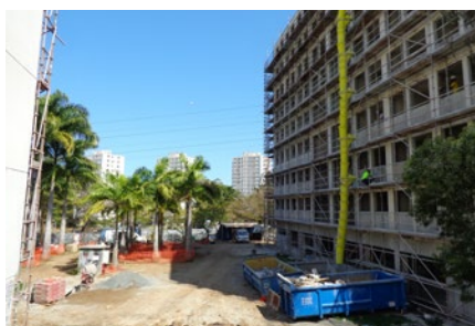
Photo 13 : goulotte d'évacuation des déchets, chantier Coeur historique de Saint-Quentin. Crédit : CCI-NC.
