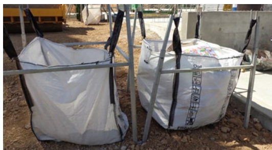
Photo 10 : zone de tri secondaire, chantier du centre aquatique de Magenta. Crédit : CCI-NC.
