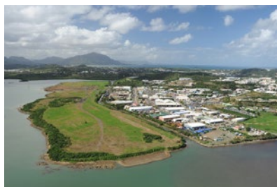
Photo 1 : plateforme d'endigage de Koutio-Kouéta. Crédit : province Sud
